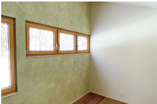
(左) 大理石粉末を混ぜてパターン付けした仕上げ (右) 通常仕上げ
